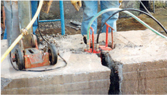
Spalten mit Presszylindern
